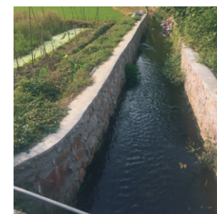
水利三面光项目建设
