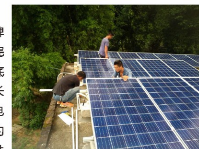
▲ 村民在屋顶安装太阳能电池板
